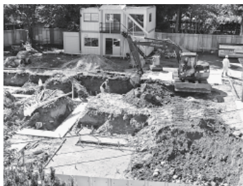
新実習棟兼女子寮の建築が順調に進んでいます。現在基礎工事を行っています。 (H26. 10. 7撮影)
