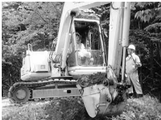
2 学年 5 月 車両系建設機械技能実習
