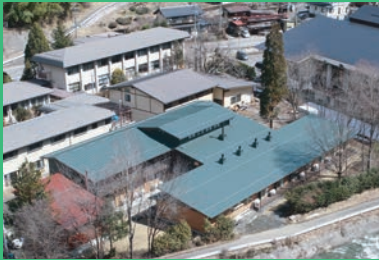
令和4年2月新学生寮完成
