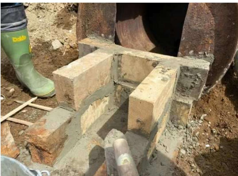
このように焚口から直接火が窯の中に入らないように障壁を作ることで燃え尽きるのを防止
